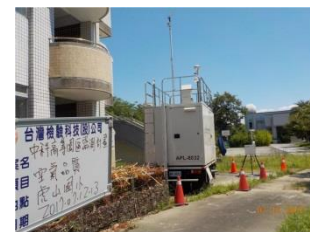
虎山國小環境現況
