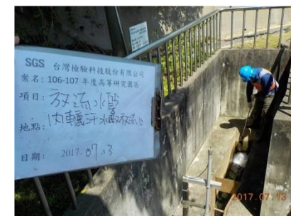
內轆污水廠放流口
