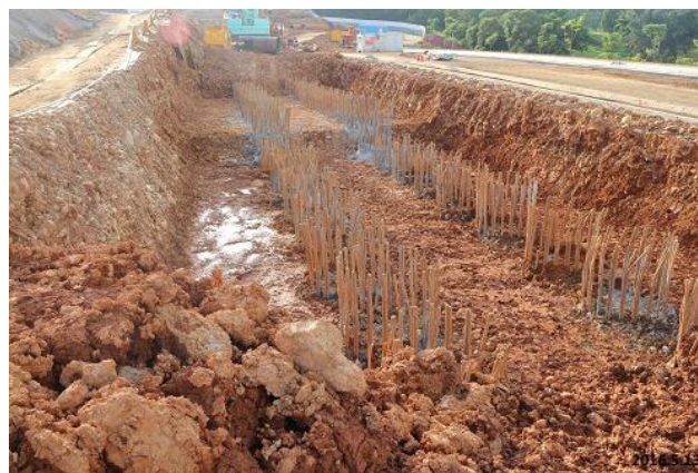
房基地整地工程
