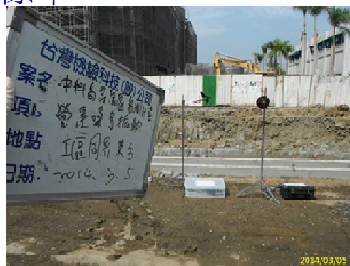
工區周界東方
