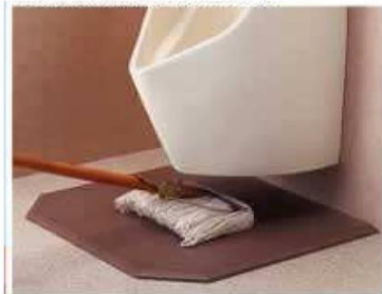
圖 3-26 小便器下方之清掃空間
