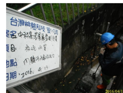
內轆污水廠放流口
