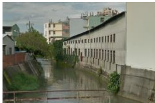
筏子溪上游生活污水排放現況
