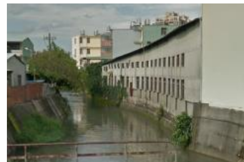
筏子溪上游生活污水排放現況
