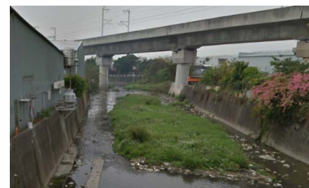
筏子溪上游生活污水排放現況
