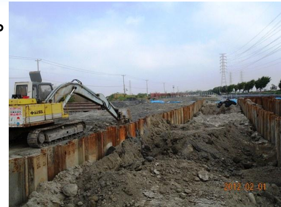
24公尺道路及管線工程開挖
