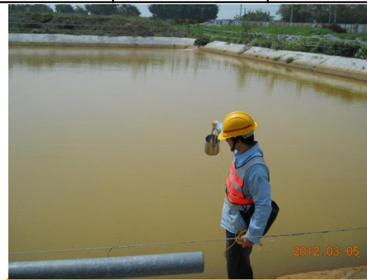
彰129與彰130交叉口沉砂池排放口
