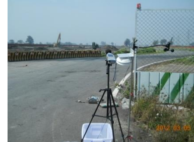
60米道路終段營建工程噪音振動監測
