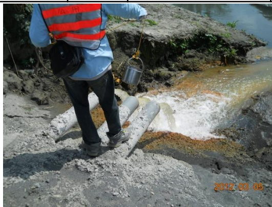
彰129萬芳橋旁沉砂池排放口
