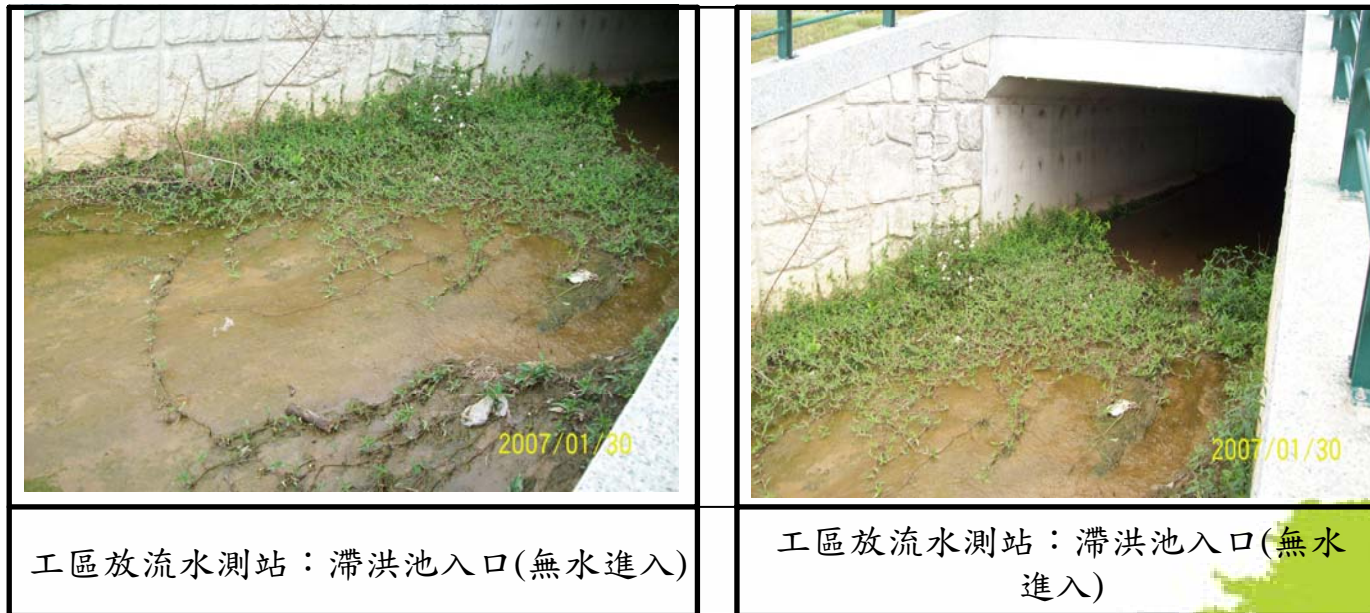
圖2工區放流水監測情形
