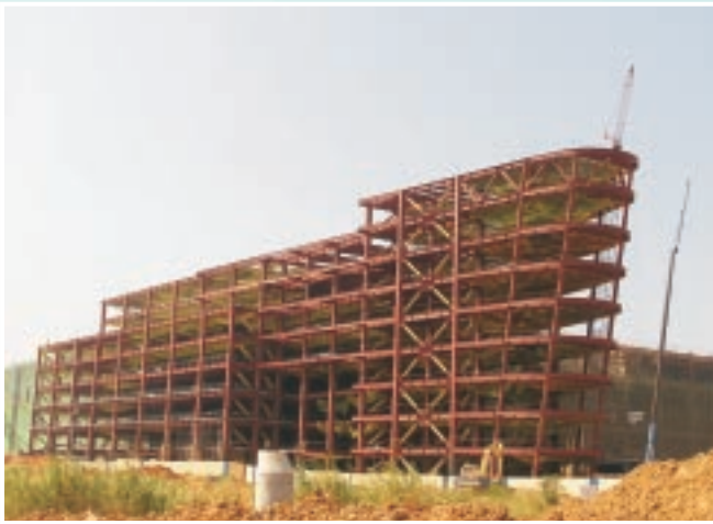
茂德科技旗艦意象的辦公室空間已完成鋼構組立
