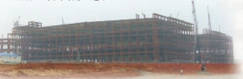
友達光電第二期7.5代廠房已開始外牆構築
