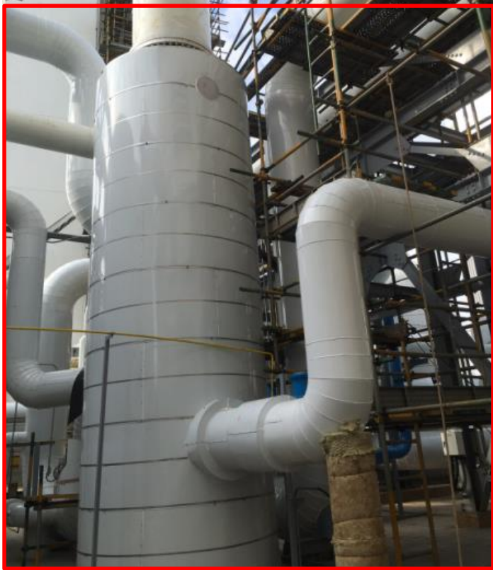
消音器及氮氣排放管線包覆
