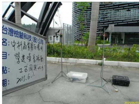
工區周界北方
