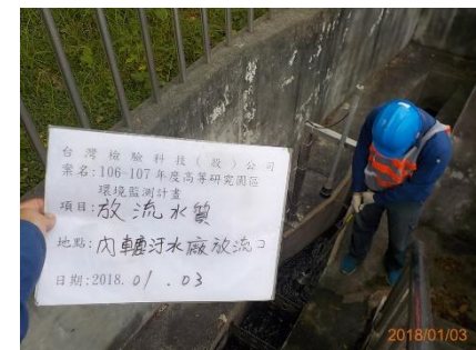
內轆污水廠放流口
