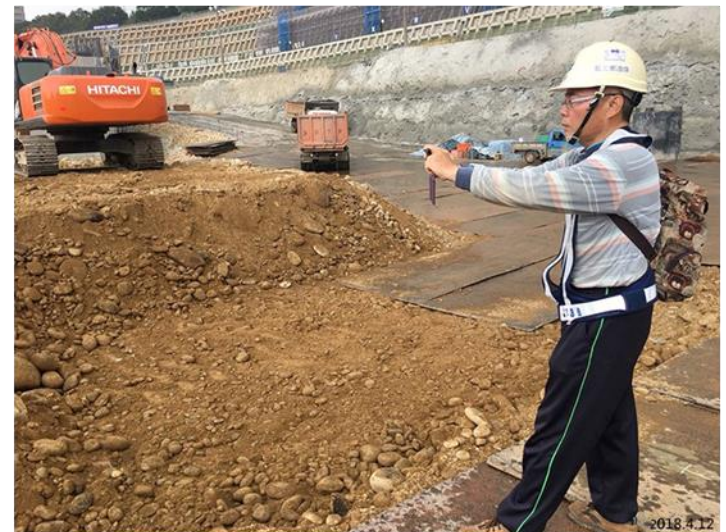
台積電中科十五廠7期興建工程(107.4.12)
