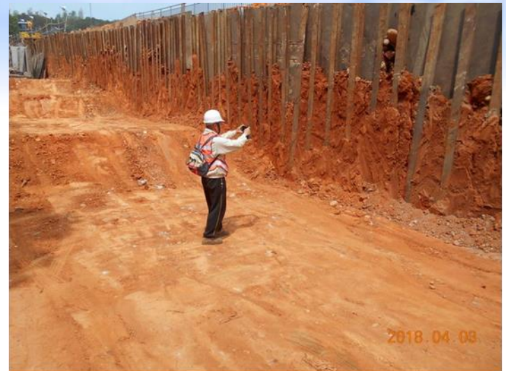
西區配合工程及景觀工程(107.4.3)
