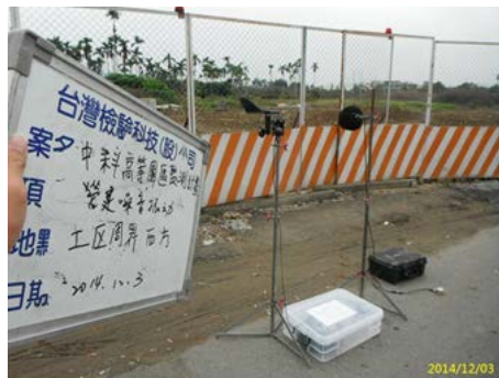
工區周界西方
