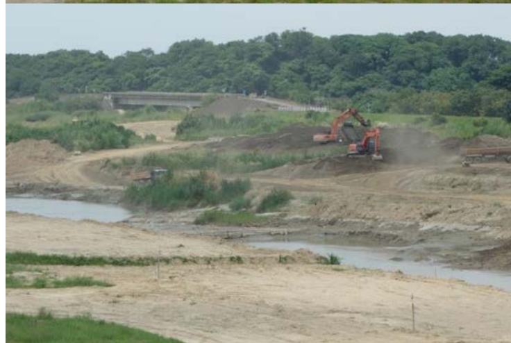
貓羅溪沿線局部河段進行整治工程
