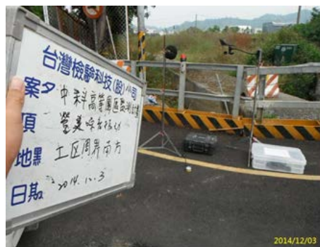
工區周界南方
