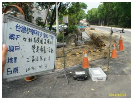
工區周界北方
