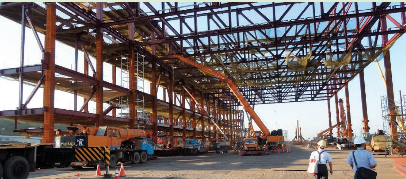
營建工地進行勞動監督檢查與輔導。
