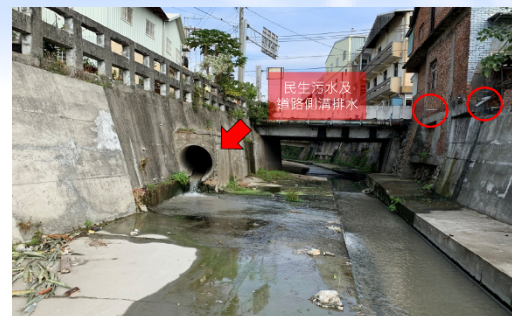
和平橋(旱溝排水)現場環境
